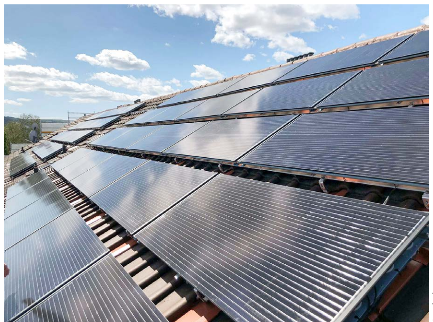
Hybride Kollektoren ermöglichen eine ähnlich hohe Effizienz, wie man sie von Wärmepumpen kennt, ohne jedoch Erdsonden zu benötigen.
