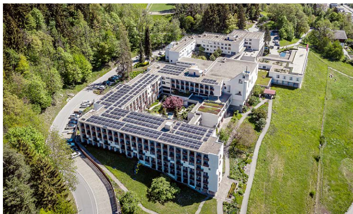
Strom aus den Alpen ohne Landverbrauch: Unsere Anlage auf dem Kloster Ilanz im meist nebelfreien Vorderrheintal.
