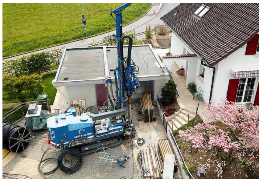
In Zukunft ein noch häufigeres Bild: Bohrung zum Einbau einer Erdwärmesonde
