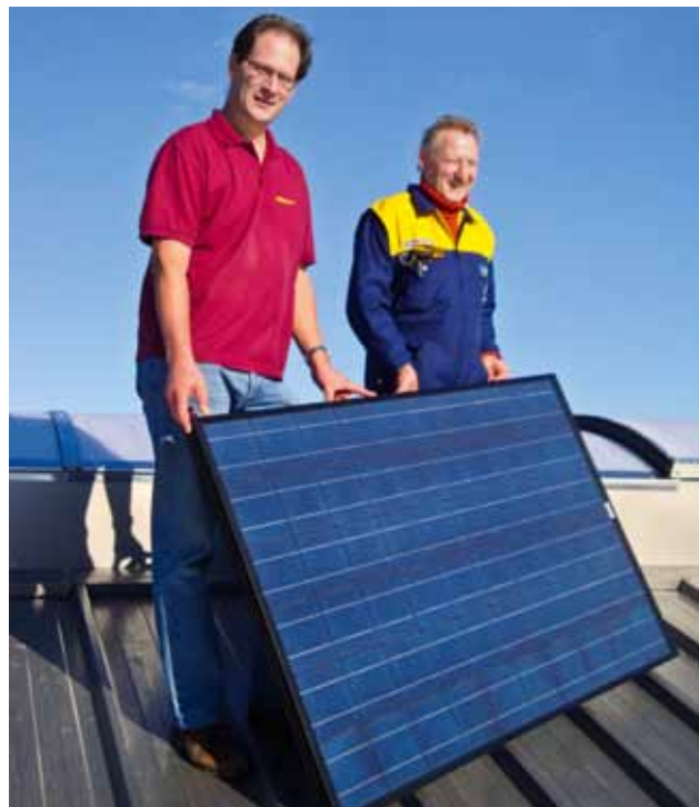
Dachbesitzer Walter Lüscher (rechts) aus Bertschikon zeigt zusammen mit Solarspar Vorstandsmitglied Andreas Dreisiebner ein Photovoltaikpanel vor der Montage.
