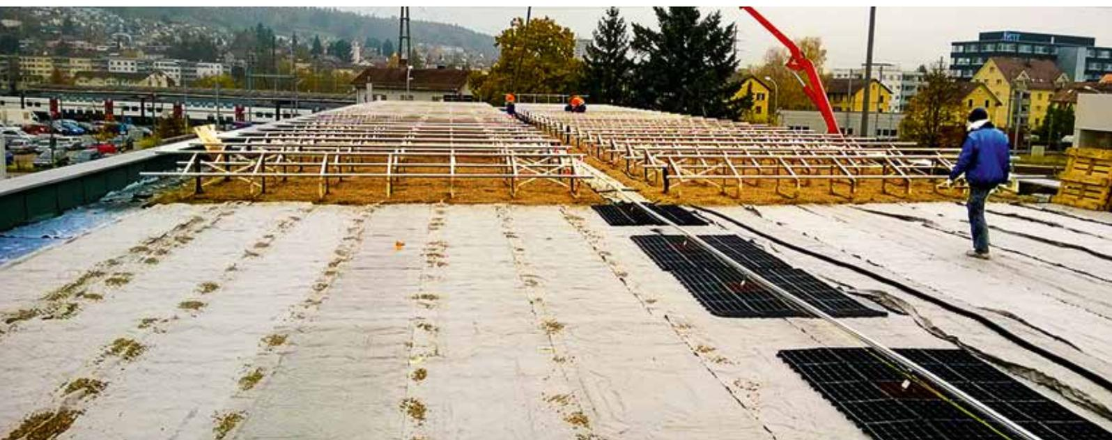
Die Solarspar-Versuchsanlage auf dem Dach des Winterthurer Werkhofs nimmt Gestalt an: Hier wird das Dach begrünt und untersucht, wie verschiedene Bepflanzungen die Stromproduktion beeinflussen.
