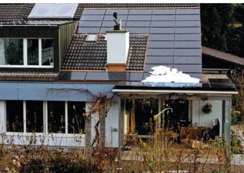
Im Rahmen einer Dachsanierung wurde eine 60 m 2 Fotovoltaik-Anlage montiert, die jährlich rund 8'500 kWh liefert.
