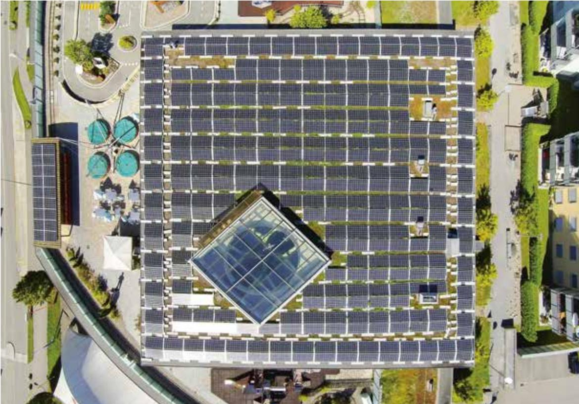
Das Solarkraftwerk auf dem Dach der Kindercity verfügt über eine Leistung von 113.68 kWp und wird gute 100 000 kWh Sonnenstrom pro Jahr produzieren. Die Batterie hat eine Kapazität von 22 kWh.
