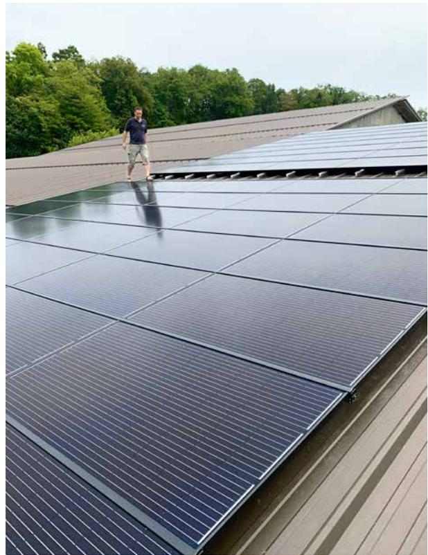
Kleine Anlage auf grossem Dach: Eine neue stärkere Erschliessungsleitung für eine grössere Anlage hätte nicht rentiert.
