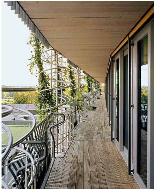
Von den Jahreszeiten gesteuert: Wechselgrüne Ranken beschatten die grossflächigen Fenster. Meili Peter Architekten, Centro Helvetia, Mailand, 2009
