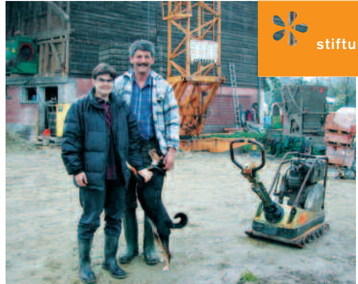
Elsbeth und Béat Aeberhard sind Solarpioniere im Kanton Fribourg. Zurzeit wird der Bauplatz für den neuen Stall vorbereitet, dessen Dach das grosse Solarkraftwerk bilden wird.
